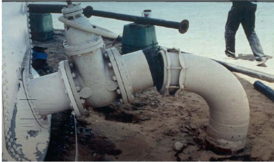
Εικόνα 19: Αστοχία σε ακροφύσιο.
