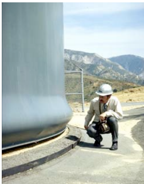
Εικόνα 17: Λυγισμός μορφής «Elephant's-foot»
